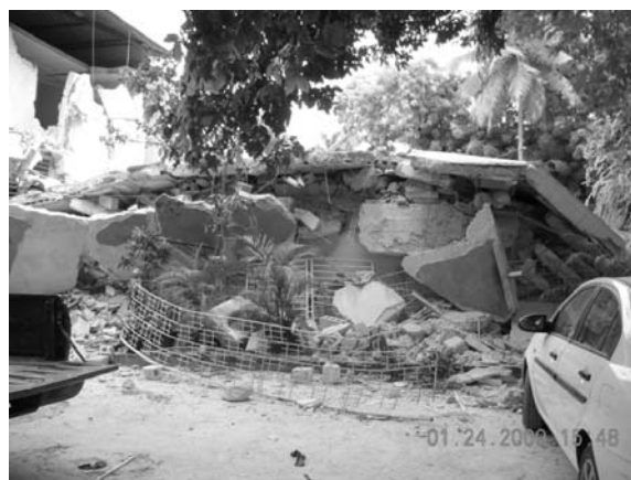
Estado actual del edificio sede del CNIGS Haití
