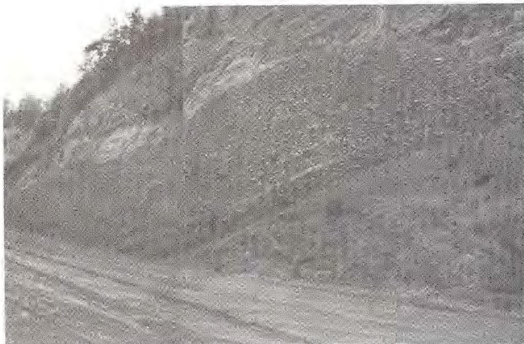
Nueva carretera "costanera sur" cerca del puente del río Tárcoles. Los depósitos fluviales (pudingas y limos) están basculados y afallados.
