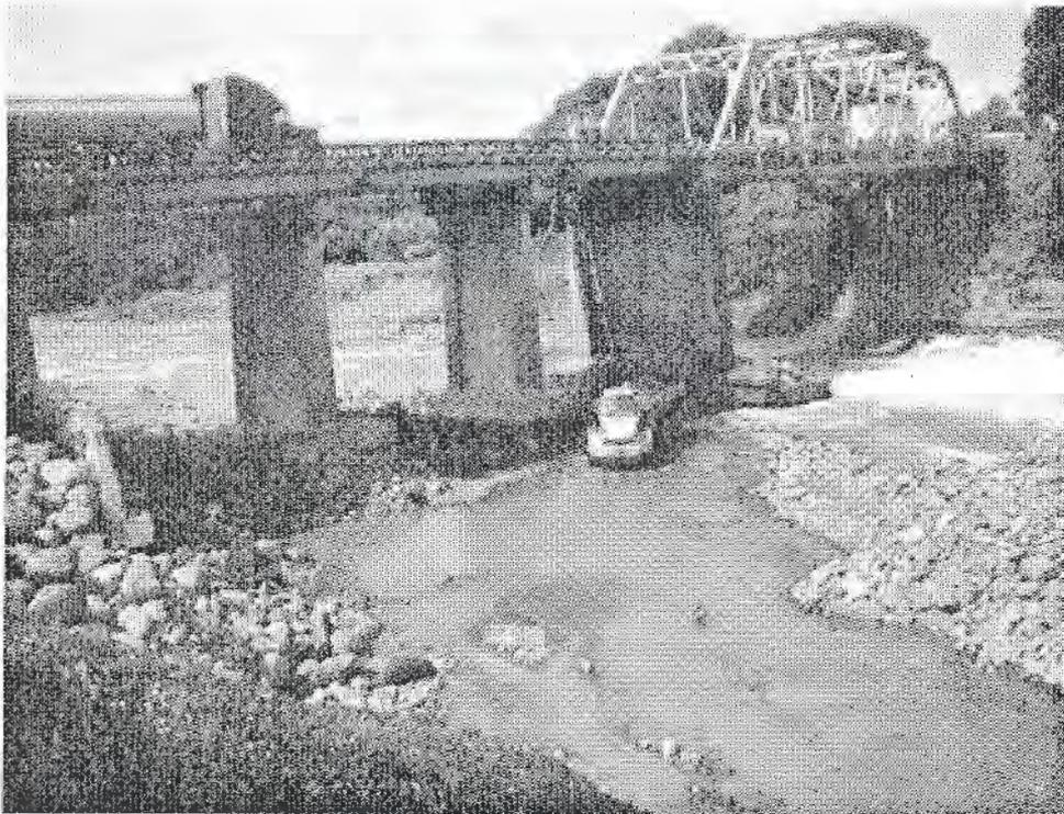
**Figura 3.** Sobre explotación del cauce del río Barranca que ha llegado a erosionar hasta la base de los pilares del puente de la interamericana (fotografía del autor).
