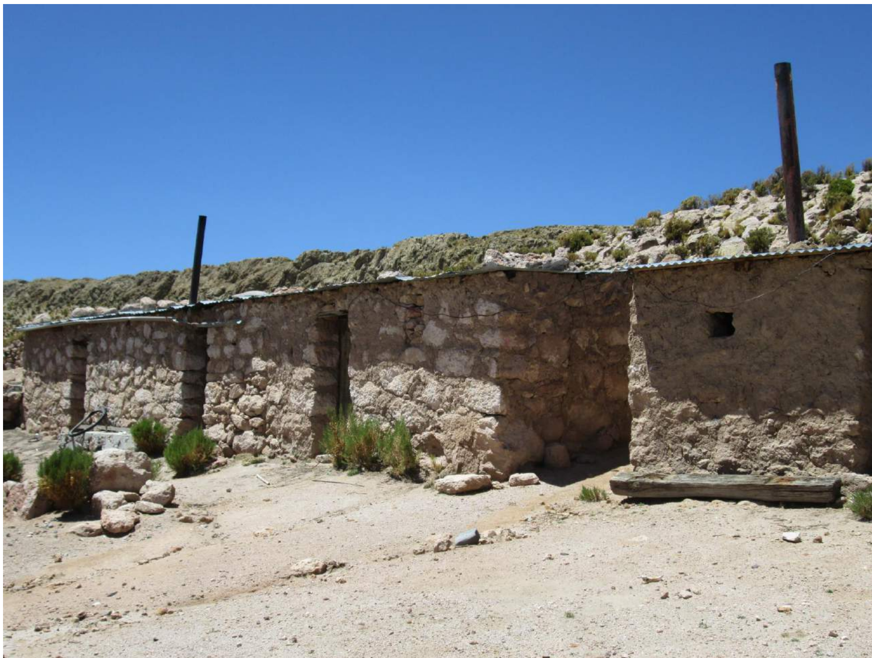
Recintos habitacionales en sector de Collumi, febrero 2016. Fotografía Jorge Moreira.
