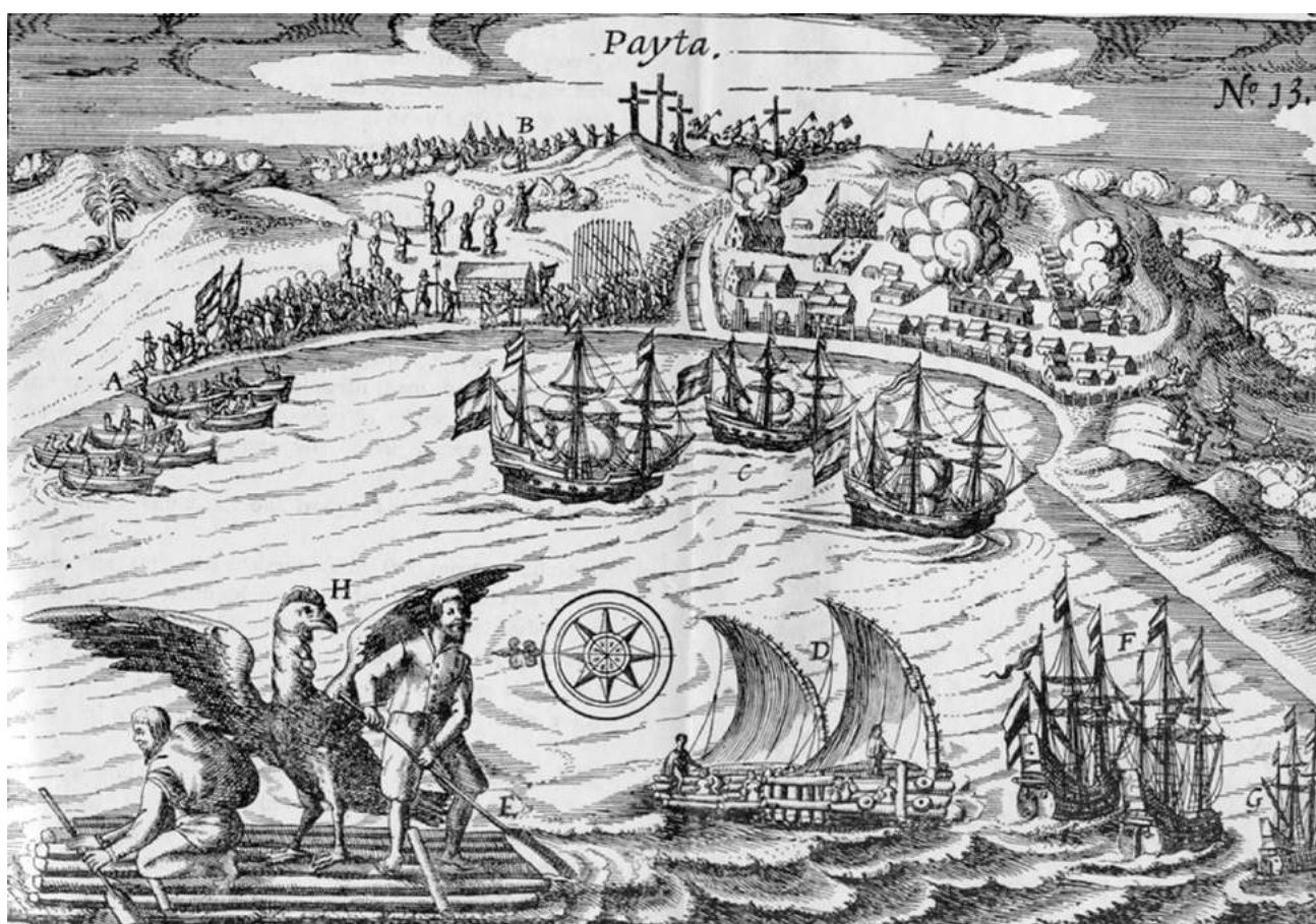
Ataque a Paita por Spilbergen, en 1615. En el primer plano, a la izquierda figura una pequeña balsa de pescadores, y al centro una gran balsa a vela con guares (Spilbergen).
